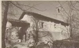
La chiesetta di S. Quirico dopo i lavori.
